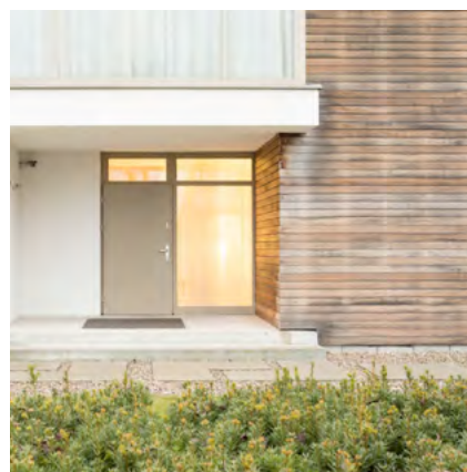
*9) gevel met houten beplating/sidings
