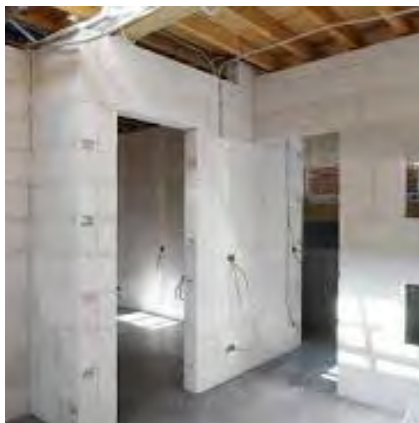
*2) wanden van gips-, of gasbetonblokken
